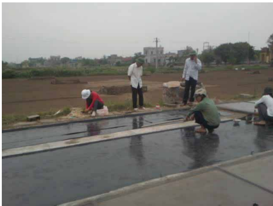
Trải bạt thử nghiệm trên nền sân kết tinh ở xóm 2, Tam Đồng
