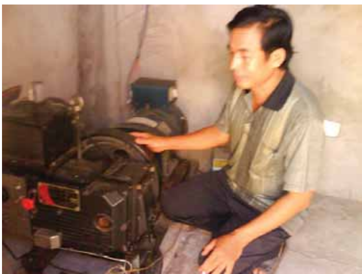
Ông Đỗ Văn Ngon bên máy phát điện sử dụng biogas
