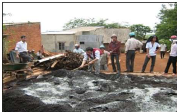
Hình 35. Phối trộn phụ gia
